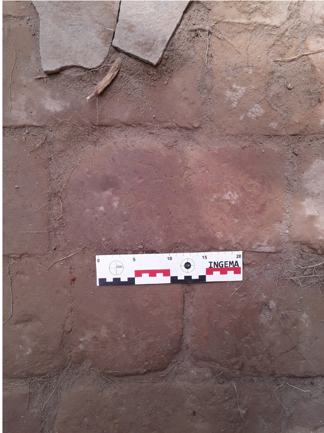
Figura 9. Contrapiso de ladrillos. Fuente: Fotografía de autor (2022)
