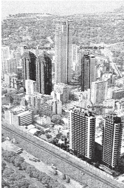
Figura 7: Vista aérea. Fuente: La Nación Arquitectura , 15 de diciembre de 1999, p. 5.
