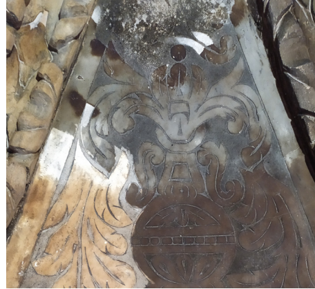
Manchas de grasa (RC2) Grease stains (RC2)
