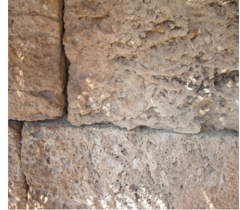
Alveolización (PF12) Alveolization (PF12)
