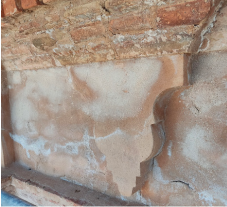
Eflorescencia (RE1) Efflorescence (RE1)
