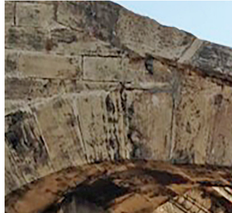
Acanaladuras (PF8) Grooves (PF8)
