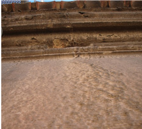
Concrecionado (PF13) Concreting (PF13)
