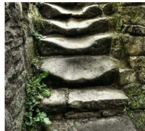
Erosión mecánica (PF6) Mechanical Erosion (PF6)
