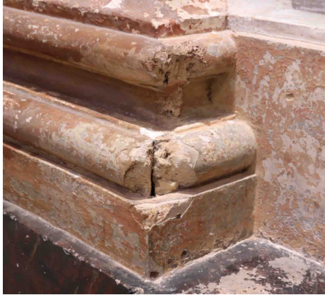
Fisuras y grietas (RF1) Fissures and cracks (RF1)
