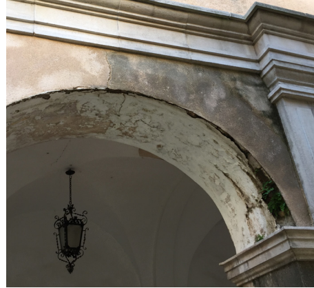
Manchas de carbonatación (RE2) Carbonation stains (RE2)
