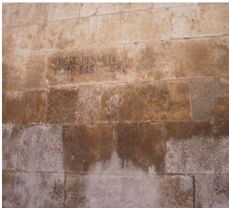
Suciedad (PC1) Soiling (PC1)
