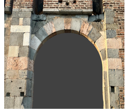
Alteración cromática (PE3) Chromatic alteration (PE3)
