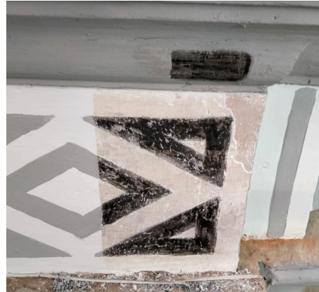
Estrato impropio (RA2) Improper stratum (RA2)
