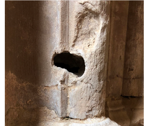
Vaciado (PF15) Emptying (PF15)
