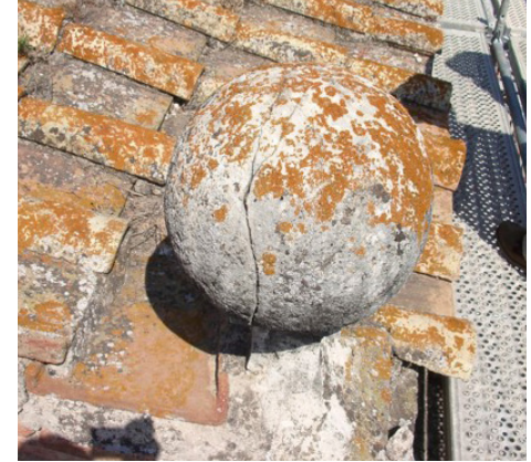
Incrustación (PB3) Incrustation (PB3)
