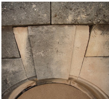
Vaciado de juntas (PF4) Joint emptying (PF4)
