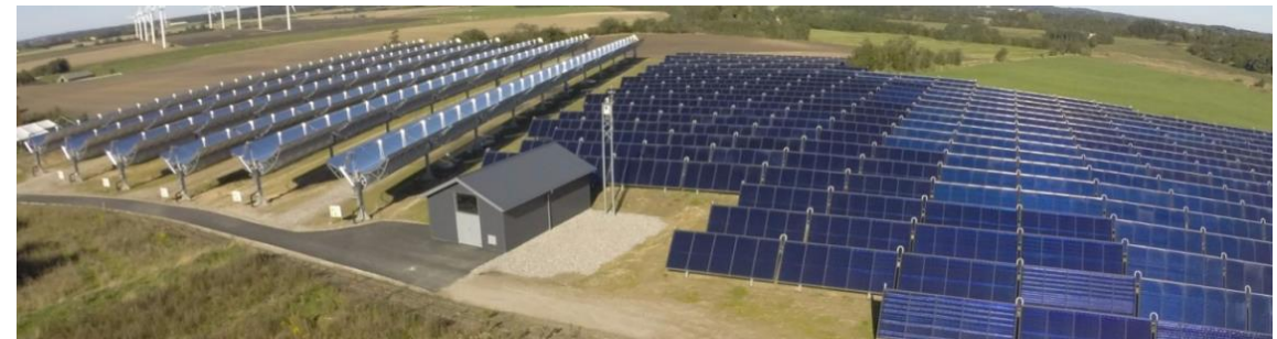
Aalborg CSP Kollektoren und Flachkollektoren. Aufteilung Solarfelder: 5960 m 2 Flachkollektor (40°C → 70 °C); 4039 m 2 Parabolrinnenkollektor (70°C → 98 °C)
