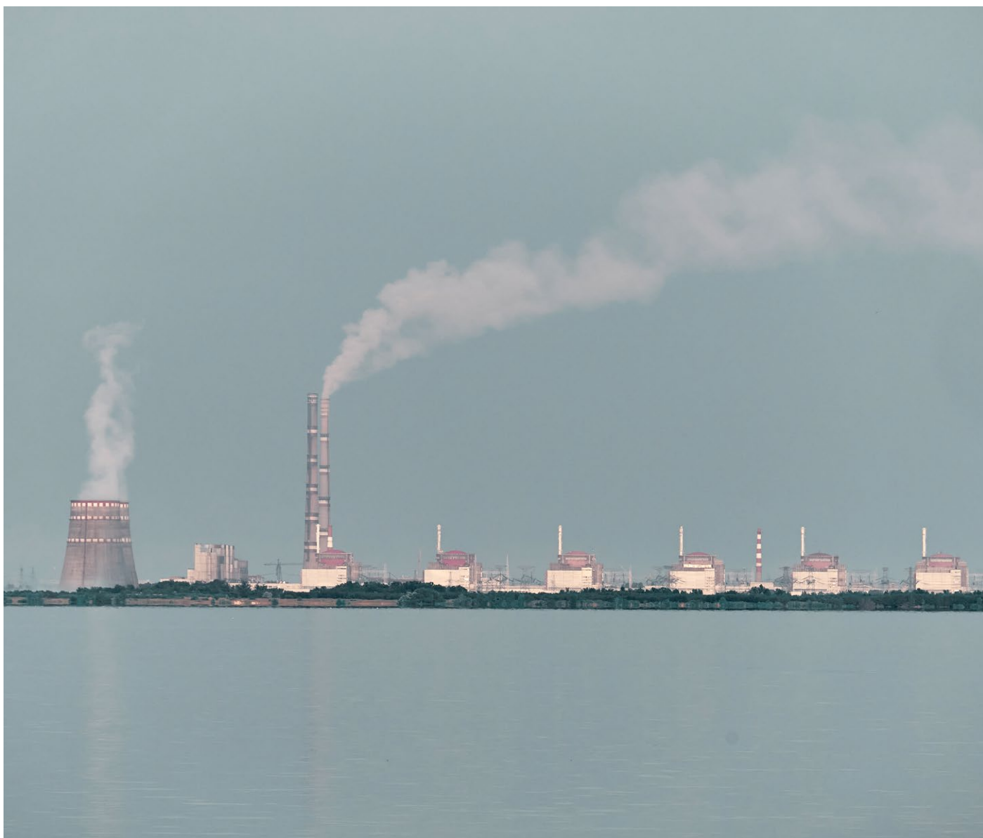
| Obr. 3: Zápotožská jaderná elektrárna |
