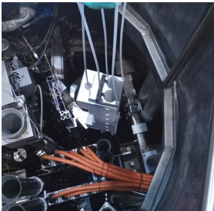
Obr. 5: Zavezení sestavy držáku ozařovacího zařízení do reaktoru LVR-15
