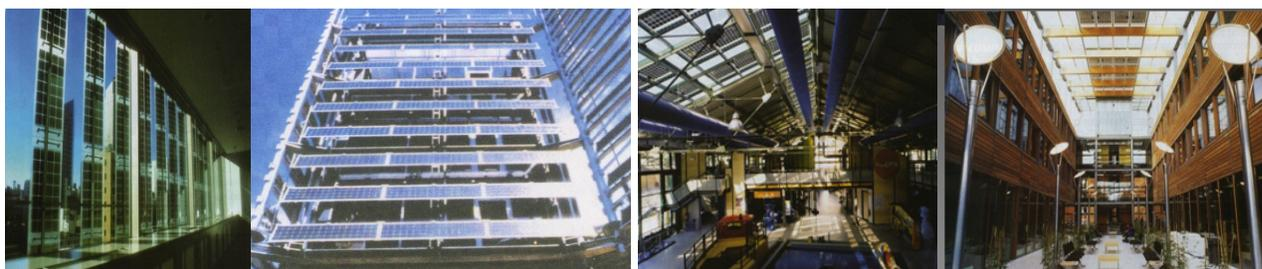
**Figura 2.30:** parasoles fotovoltaicos (izq.) y en paneles en lucarnas de techos (der.) [15]
