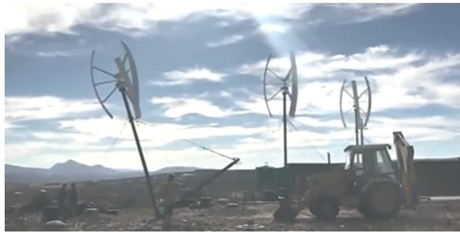
Figura 2.25: Izamiento de turbina Darrieus y torre con soporte L, malacate y linga.
