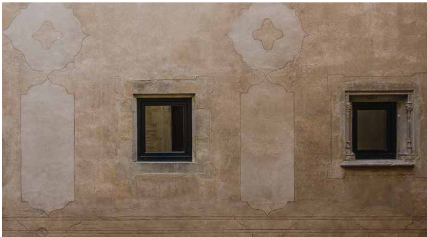
Estuco esgrafiado del patio interior de un antiguo Palacio situado en la calle de la Mercè, 17-19 Sgraffito stucco of the inner courtyard of an old Palace located on Carrer de la Mercè, 17-19
