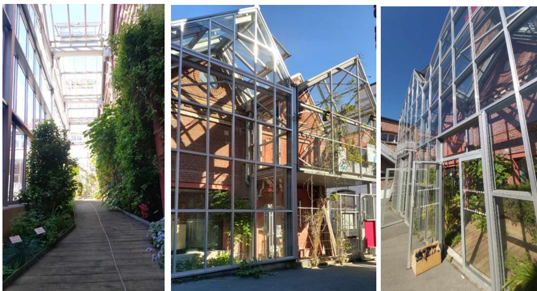
Figure 3 : Vue sur « l'espace Végétale » de la maison de l'habitat durable à Lille. Source : Auteur
