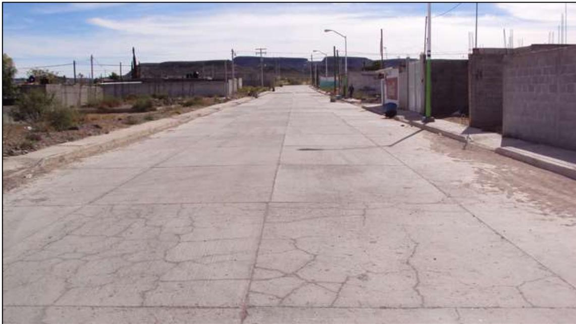
*Nota.* Imagen que muestra las fisuras en los pavimentos de concreto por retracción superficial. De “Cómo prevenir las fisuras en los pavimentos de concreto”, por I. Hernández, 2013 (<https://360enconcreto.com/blog/detalle/prevenir-fisuras-en-los-pavimentos-de-concreto/>).
