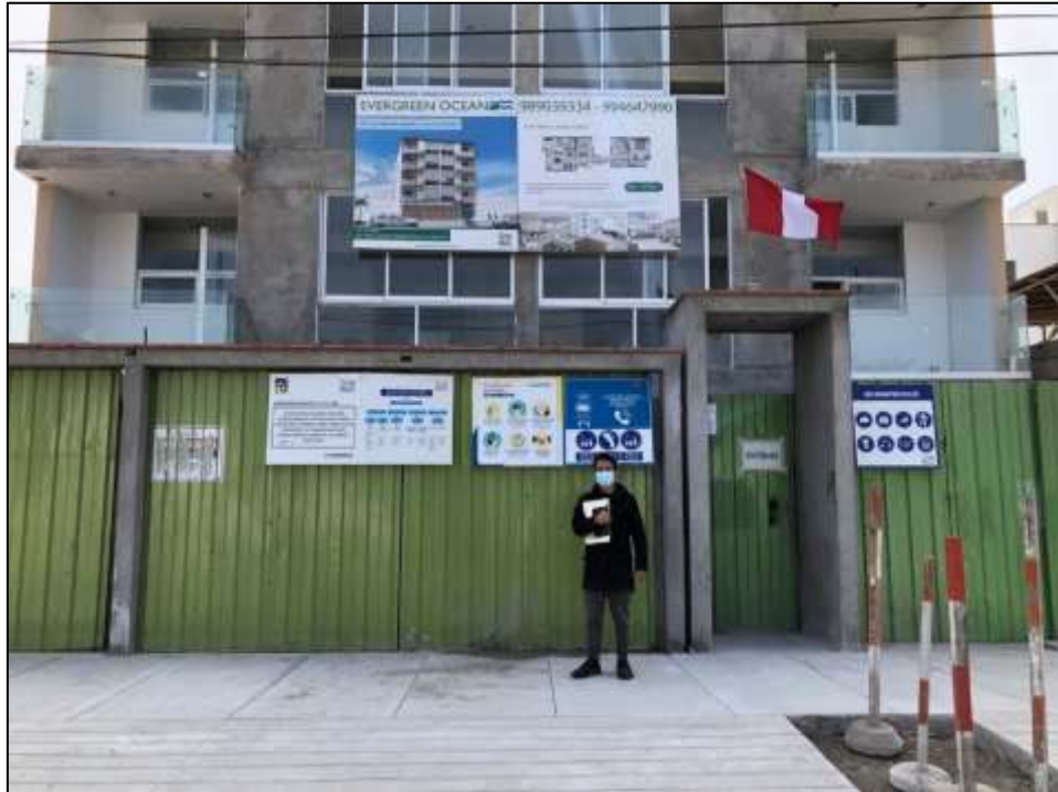
Figura 12 Construcción del proyecto Evergreen Ocean
