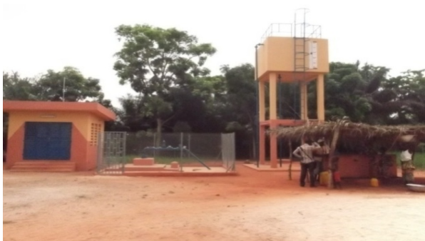
Photo 5 : Station de pompage d'eau du PEA de l'Arrondissement de Tokpa
