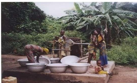
Photo 2 : Forage à pompe manuelle à DOUME LAKOUN
