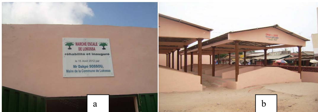
Photos 5 : Illustration du marché escale de Lokossa en réhabilitation. Prise de vue : Aïssi, août 2022.
