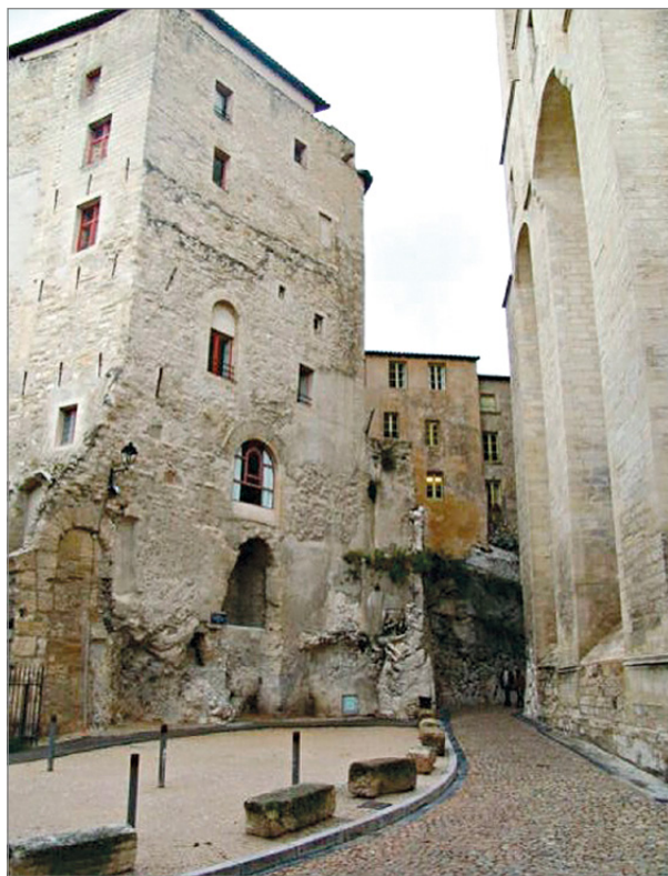
fig. 5 – Avignone, facciata settentrionale del palazzo comunale (F. Guyonnet).
