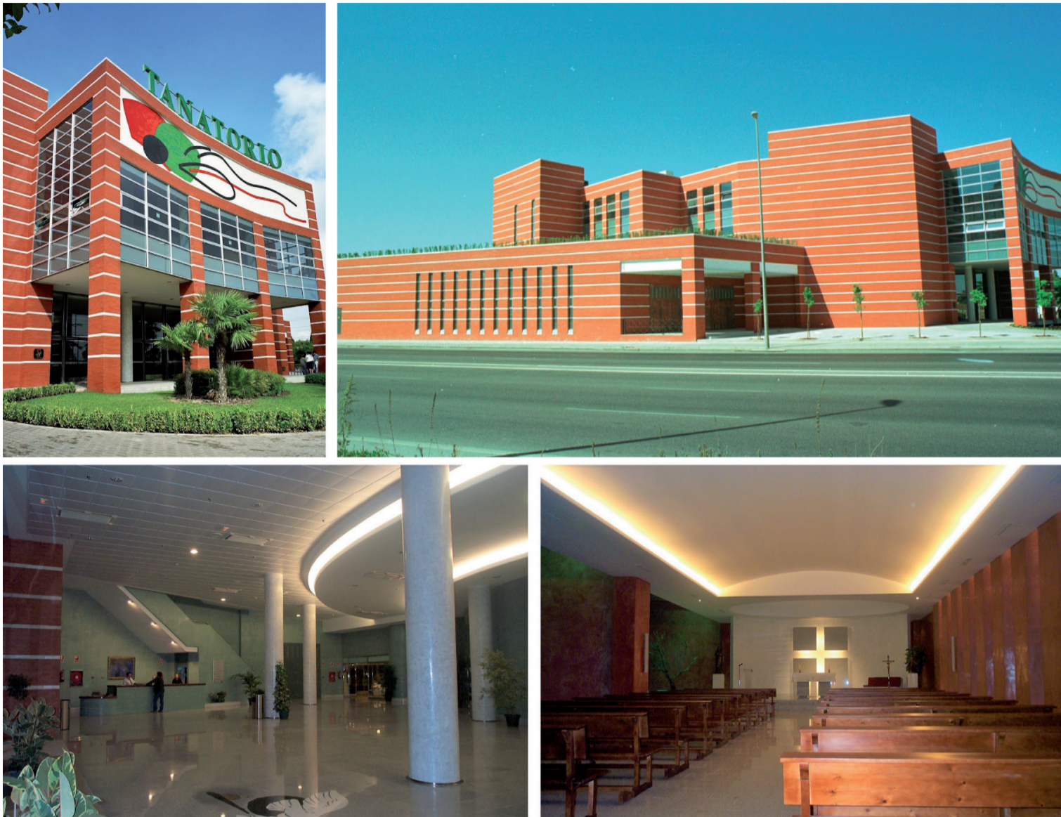
Fig. 5. Estudio Vilches, Segura y Asociados, fachada, volumetría general del tanatorio. Abajo, hall de acceso y capilla del tanatorio Ronda Urbana SE-30, 2000, Sevilla. Documentación gentileza del arquitecto Guillermo Vilches.
