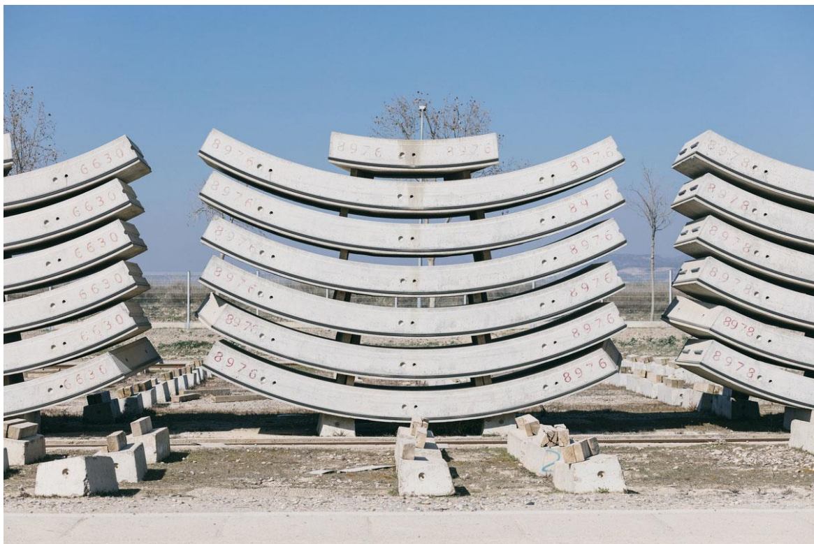
Figura II.4.34 Acopio Real de Dovelas de Hormigón prefabricadas Fuente: Curso Tunelación – Ing. Perri
