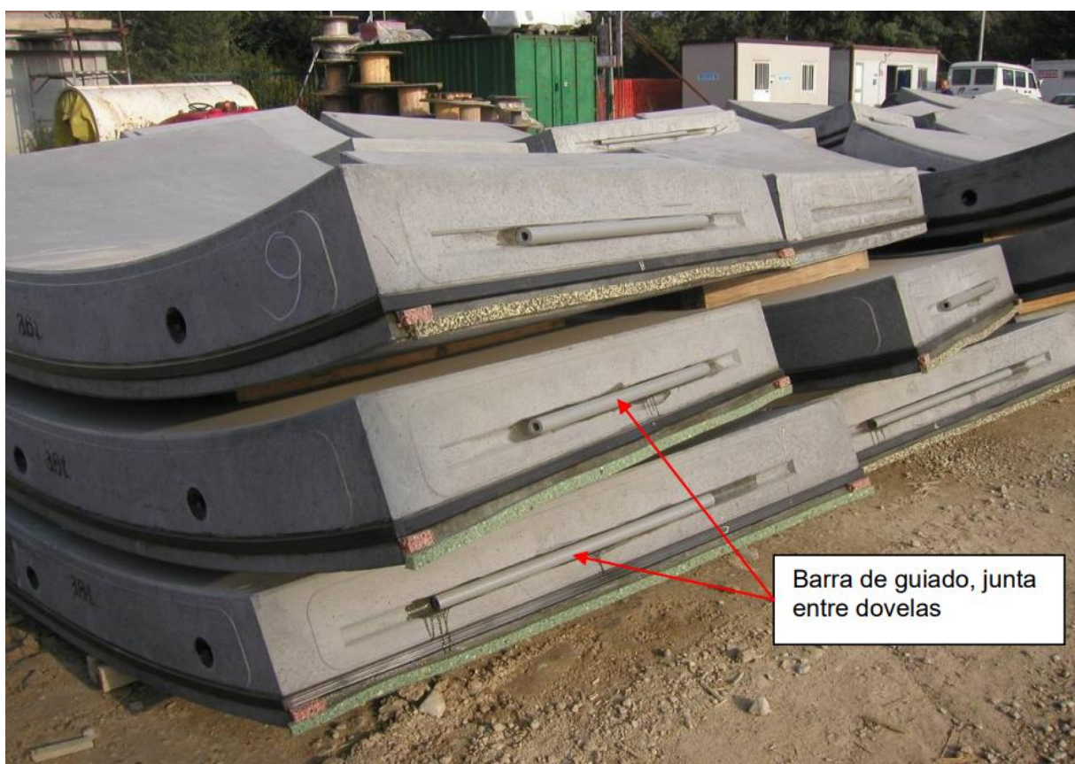
Figura II.3.2 Anillos de dovelas en acopio. Fuente: Curso de Tunelación – Ing. Perri.
