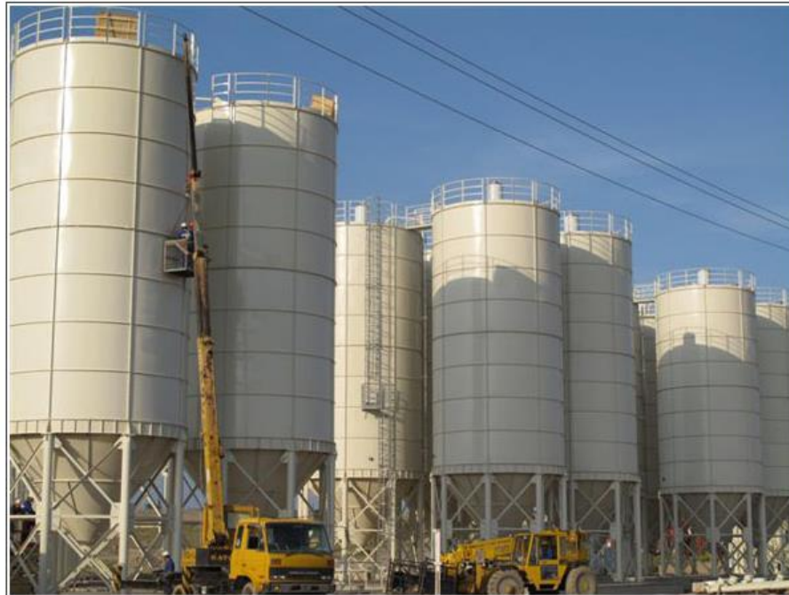
Imagen N  12: Silo Granelero
