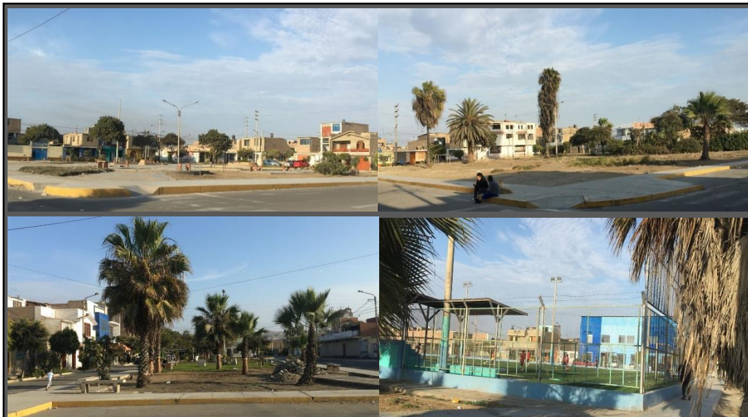
Figura 5. Collage de Asentamientos la Victoria - Espacios en deterioro por falta de apropiación con grado de conservación bajo
