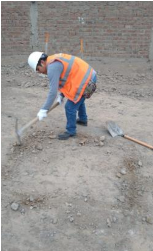
Figura 14 Inicio de las excavaciones
