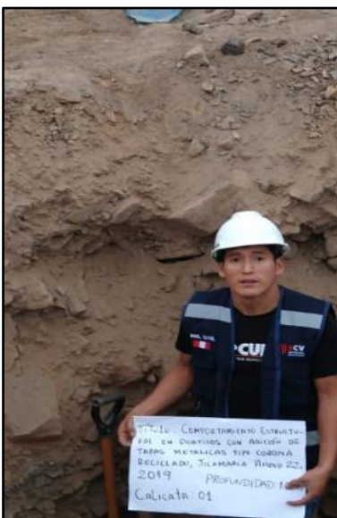
Figura 17 Calicata 1.5 mt profundo
