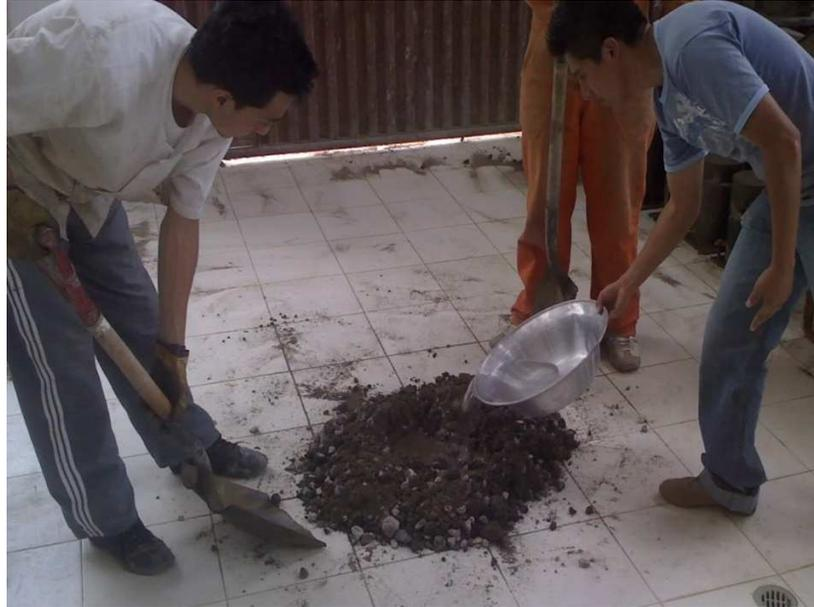
Figura 40. Homogenización de la mezcla de concreto
