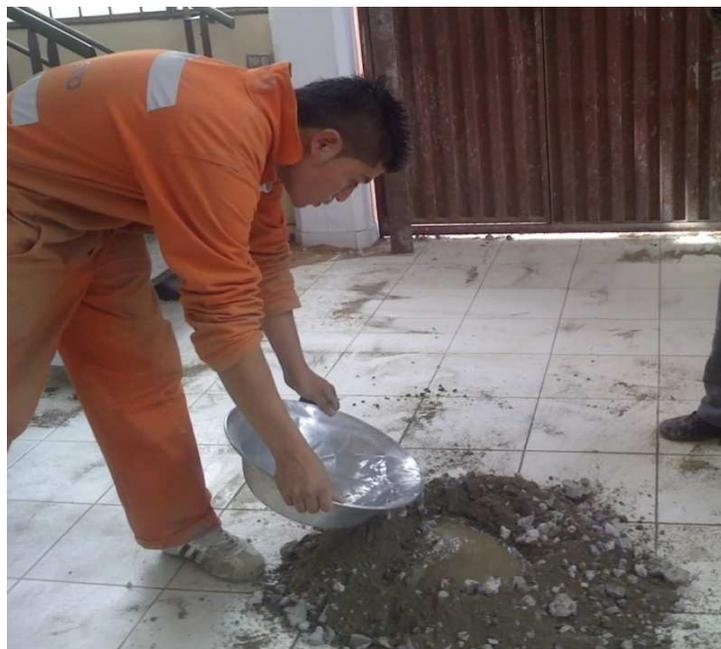
Figura 39. Adición del agua de mezclado
