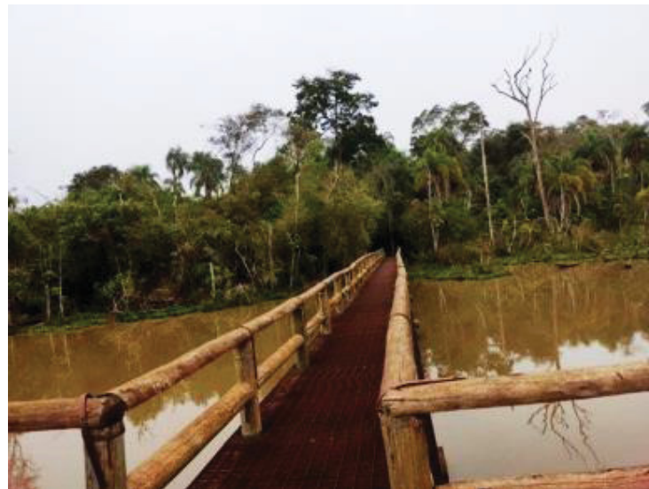
FIGURA 2 – Ponte de acesso a trilha do PESC
