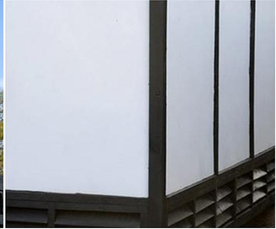
FIGURA 9 - ELEMENTO DE VENTILAÇÃO PERMANENTE NA PORÇÃO INFERIOR DA EDIFICAÇÃO (MÓDULO 10X10).
