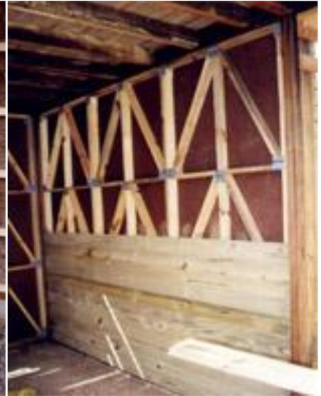
FIGURA 74 - OSSATURA DOS PAINÉIS DE VEDAÇÃO DE MADEIRA DA UNIDADE 001 (SÃO CARLOS).
