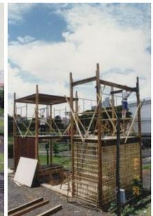
FIGURA 68 - INSTALAÇÃO DAS OSSATURAS DA UNIDADE 001 (SÃO CARLOS).
