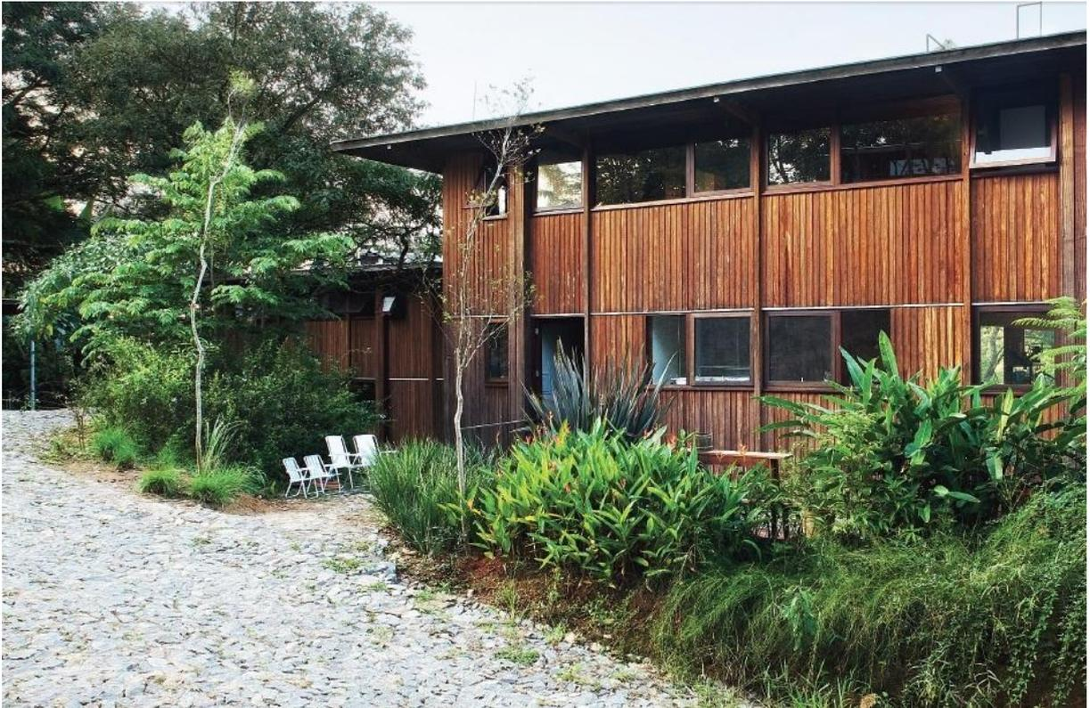
FIGURA 114 - SEM PROTEÇÃO, MADEIRA VAI VARIAR CONFORME A ESTAÇÃO DO ANO (VILA TAGUAÍ).
