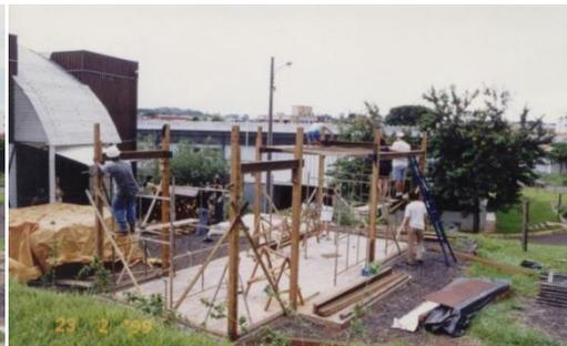
FIGURA 67 - TRAVAMENTO DA ESTRUTURA DE MADEIRA DE EUCALIPTO SERRADO DA UNIDADE 001 (SÃO CARLOS).
