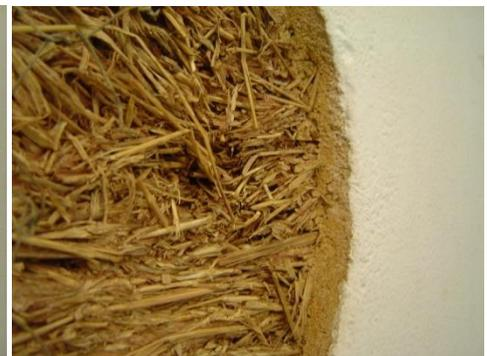
FIGURA 51 - PAREDE DE TERRA-PALHA UNIDADE EXPERIMENTAL 002 (SÃO CARLOS).
