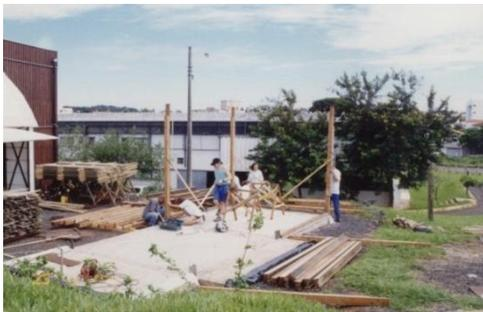
FIGURA 66 - PILARES DE MADEIRA DE EUCALIPTO SERRADO DA UNIDADE 001 (SÃO CARLOS).
