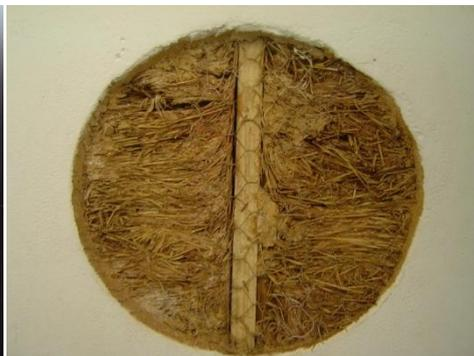
FIGURA 50 - PAREDE DE TERRA-PALHA UNIDADE EXPERIMENTAL 002 (SÃO CARLOS).
