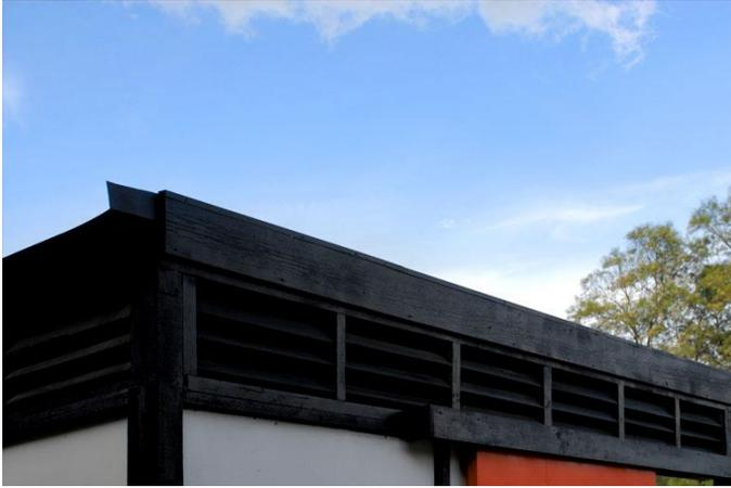
FIGURA 8 - ELEMENTO DE VENTILAÇÃO PERMANENTE NA PORÇÃO SUPERIOR DA EDIFICAÇÃO (MÓDULO 10X10).
