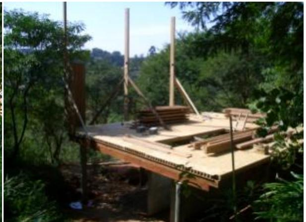
FIGURA 99 - INSTALAÇÃO DO PAINEL LAJE (VILA TAGUAÍ).
