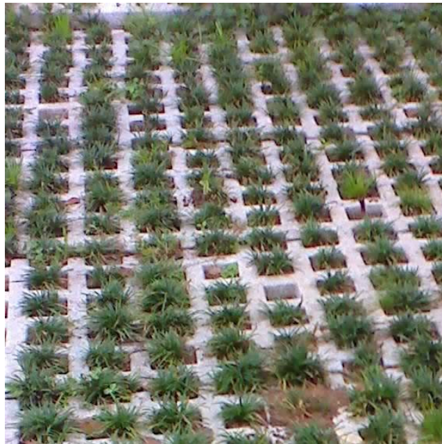
FIGURA 2.6 – Pavimento de concreto vazado. Permite tráfego de veículos e crescimento de vegetação.
