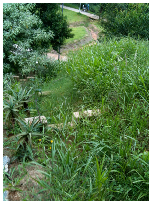
FIGURA 3.21 e 3.22 – Bio-valetas novas e após o desenvolvimento de vegetação. FONTE: Bons projetos de paisagem, 2010.
