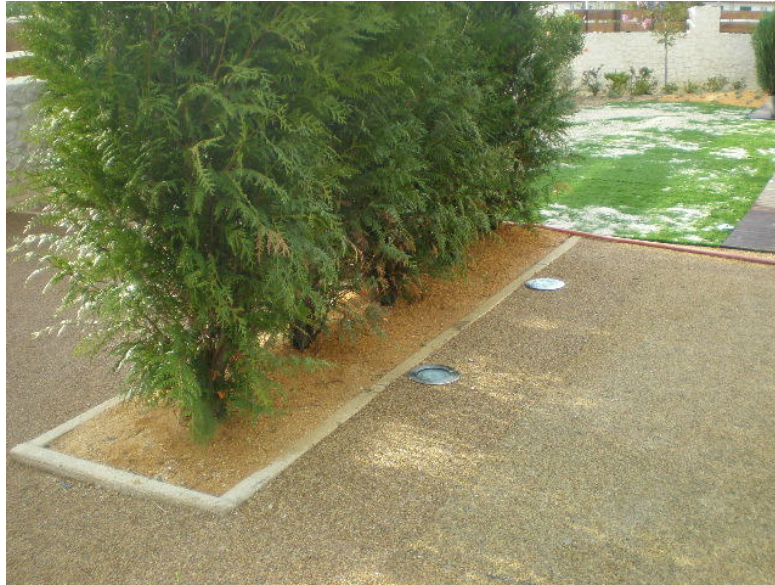
FIGURA 2.8 – Uma resina especial de nome comercial Aquastone agrega inertes de diversas qualidades, formando um revestimento quase 100% permeável. FONTE: Agraria Verde.
