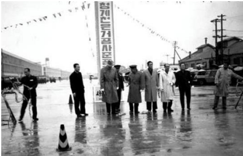
FIGURA 3.4 – Pavimentação sobre o rio, década de 1960. FONTE: SEOUL, 2006.
