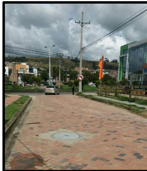
Ilustración 42 Calle 48 con Avenida Universitaria, SR-06, Tunja.
