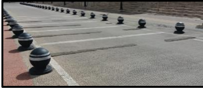
Ilustración 28 Bandas de agregado carrera 9 entre calles 19 y 20, Tunja.
