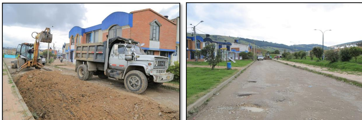
Figura 40. Intervención red vial, sector 3
