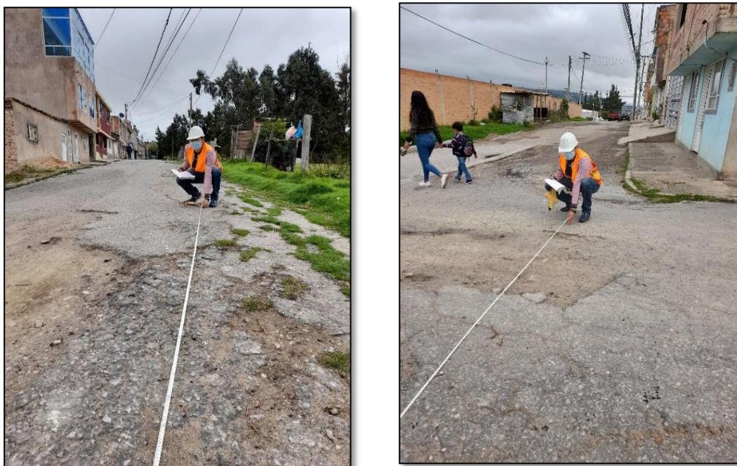
Figura 21. Inspección visual calle 8 entre carrera 1 y 2 este
