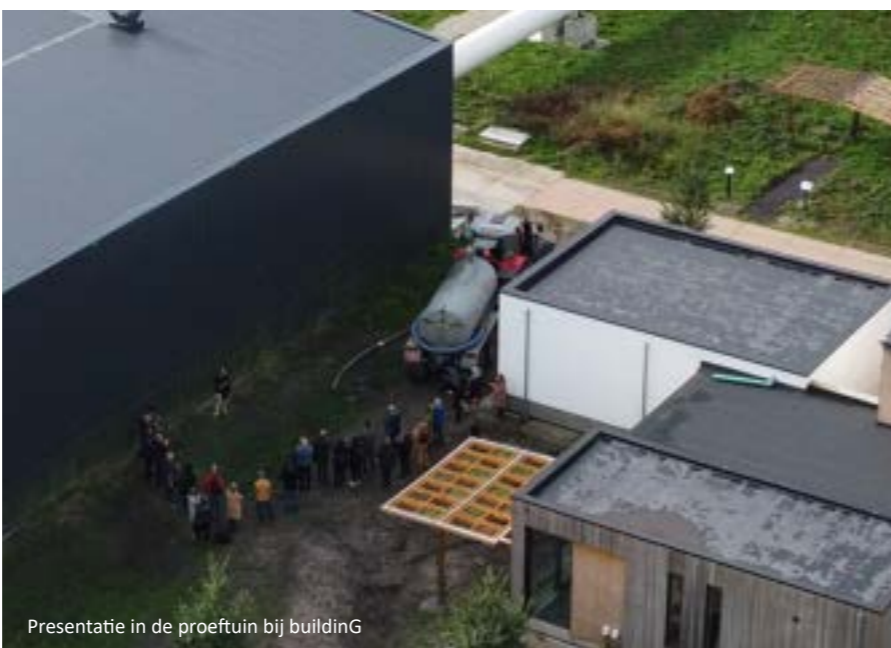
Piet Zijlstra bij plaatsing fundering
