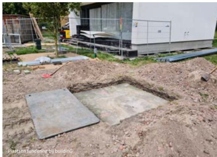
Plaatsen fundering bij building
