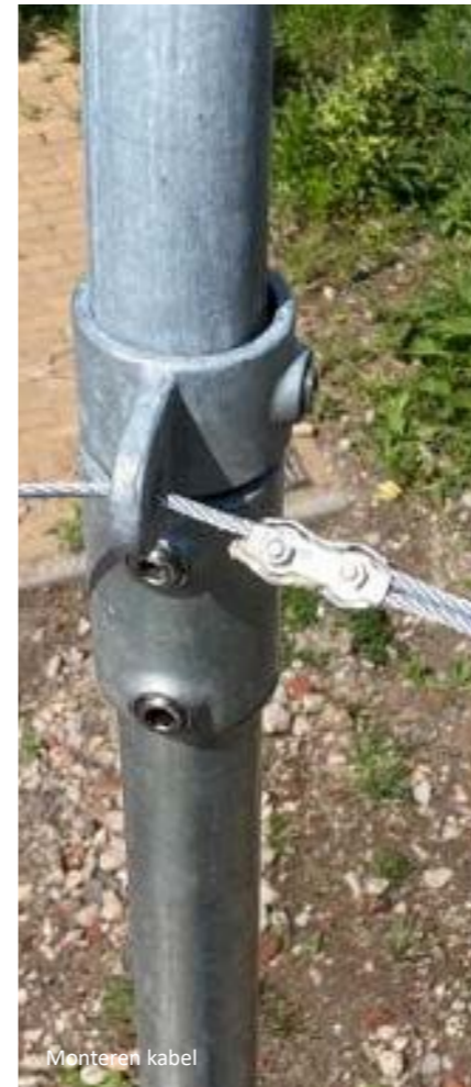
Monteren kabels en takken
