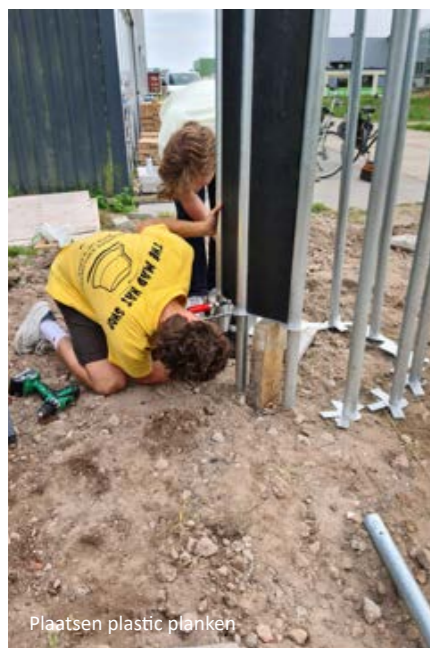
Plaatsen plastic planken
