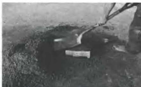
Fig. 9 Llenado y "compactación inicial".
