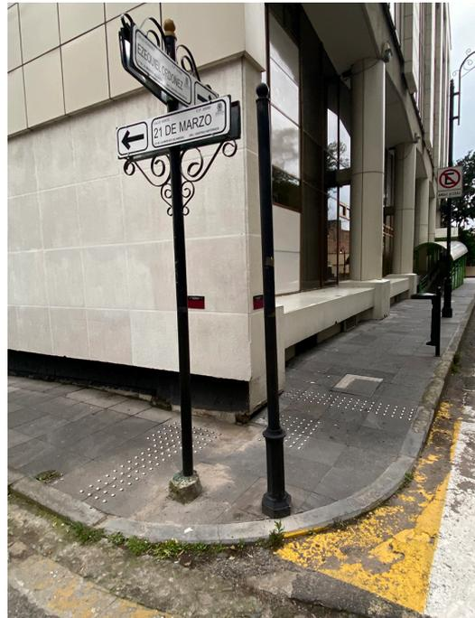
Figura 6. Colocación de guías tactopodales en las esquinas anunciando los puntos de precaución o alerta. Fotografía: Velázquez (2022).
