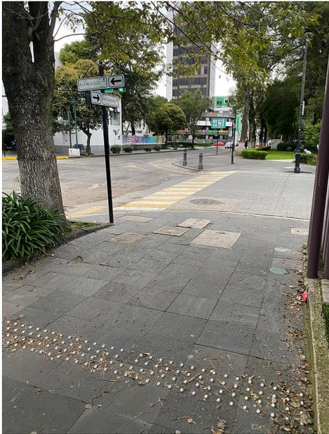
Figura 7. Ausencia de guías tactopodales para áreas de flujo o avance. Fotografía: Velázquez (2022).
