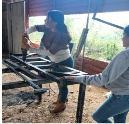
Figura 4. Estudiantes realizando las perforaciones de los soportes de los paneles solares
