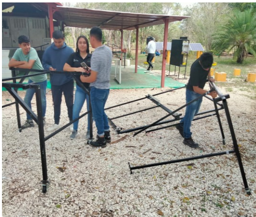
Figura 5. Estudiantes pintado y armado el soporte de los paneles fotovoltaicos
