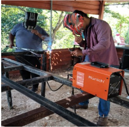
Figura 3. Estudiante soldando la estructura donde se colocan los paneles
