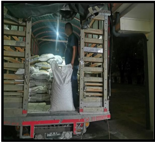
Figura 10. Ingreso de Elementos de sostenimiento.
