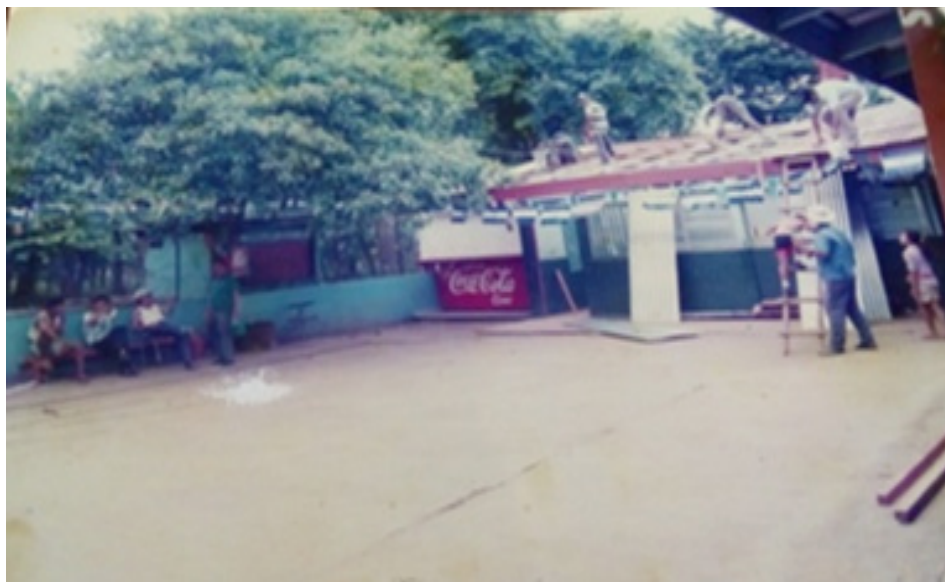
Figura 4. Pobladores colaboran en la construcción del colegio.
