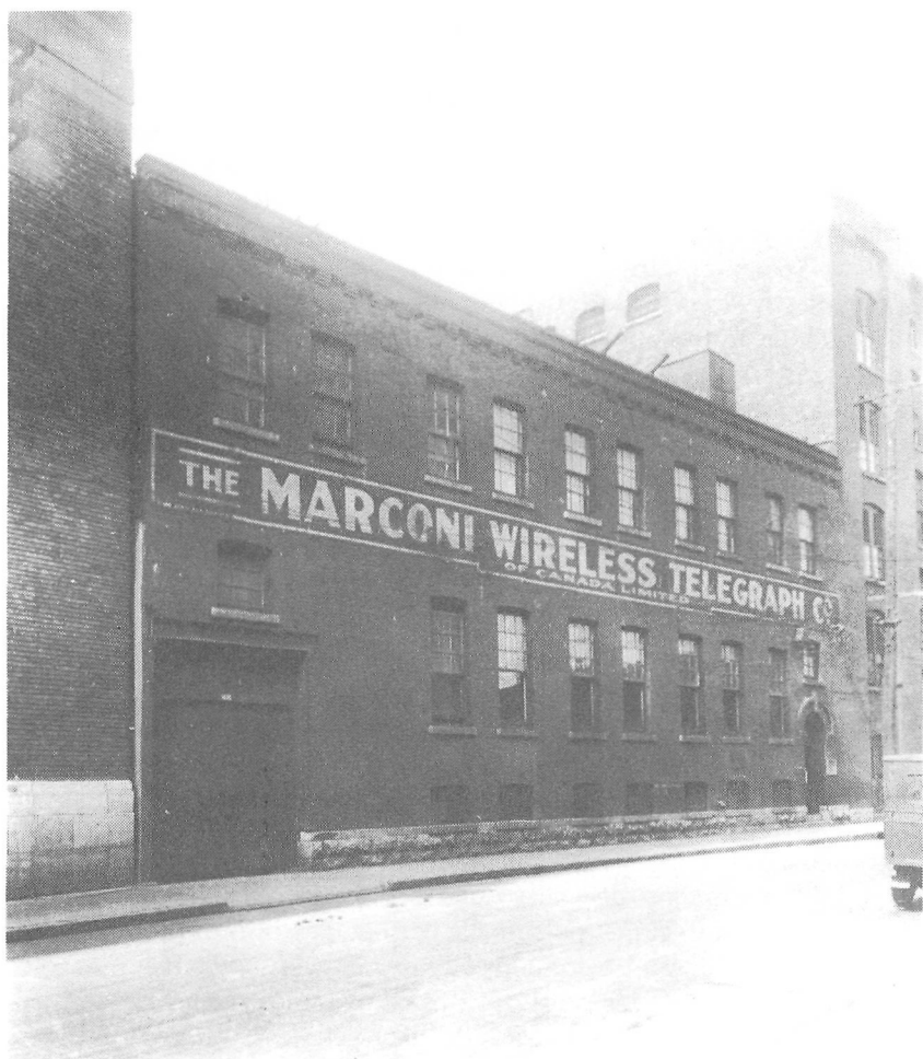
L'édifice Marconi, rue Williams dans le Vieux-Montréal qui abritait la première station radiophonique au monde XWA (devenu CFCF)
