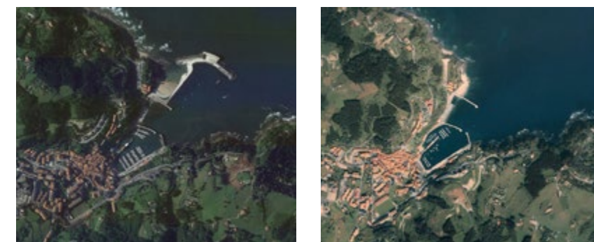
figura 10 Evolución del paisaje antes y después de la construcción del dique y la planta energética. Fuente: Imágenes de Google Earth Pro años 2001 (a) y 2018 (b) (Image©2023 Eusko Jalauritza; Image©2023 TerraMetrics; Data SIO, NOAA U.S. Navy, NGA, GEBCO).
