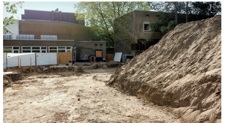
Die Baugrube für die Erweiterung der Kita Plötzensee
