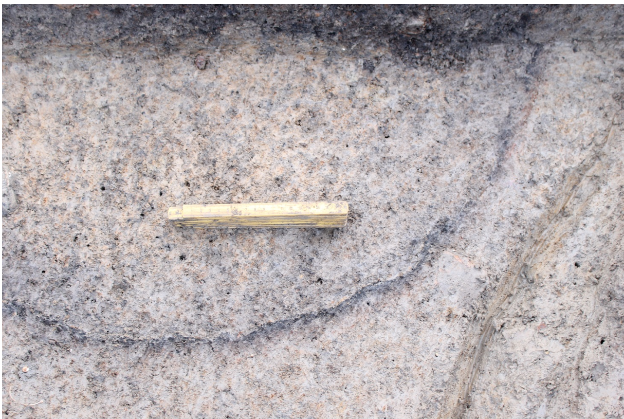
Figur 11: A97 Ildpåvirkning langs anlæggets kant.
