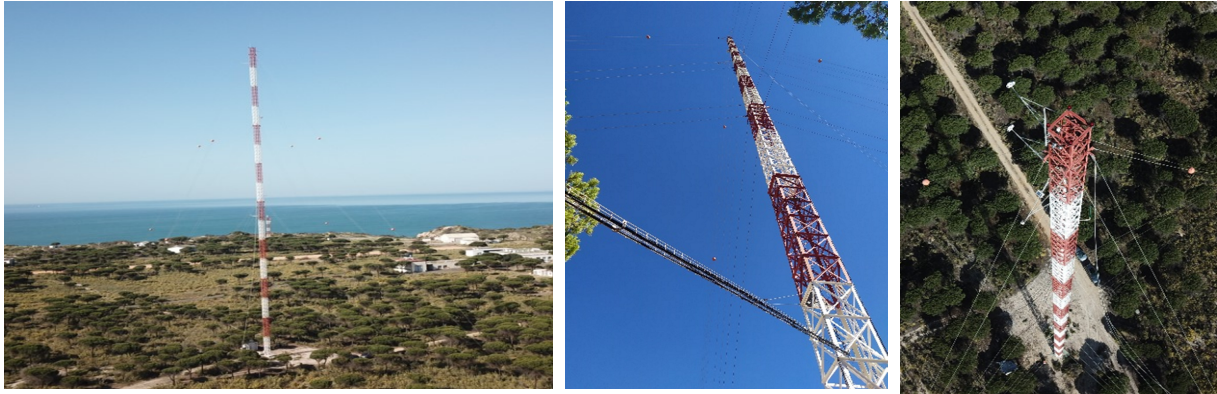
Figura 8. Torre de El Arenosillo donde se miden concentraciones de GEI y de parámetros meteorológicos en los niveles de 10, 50 y 100 m.
