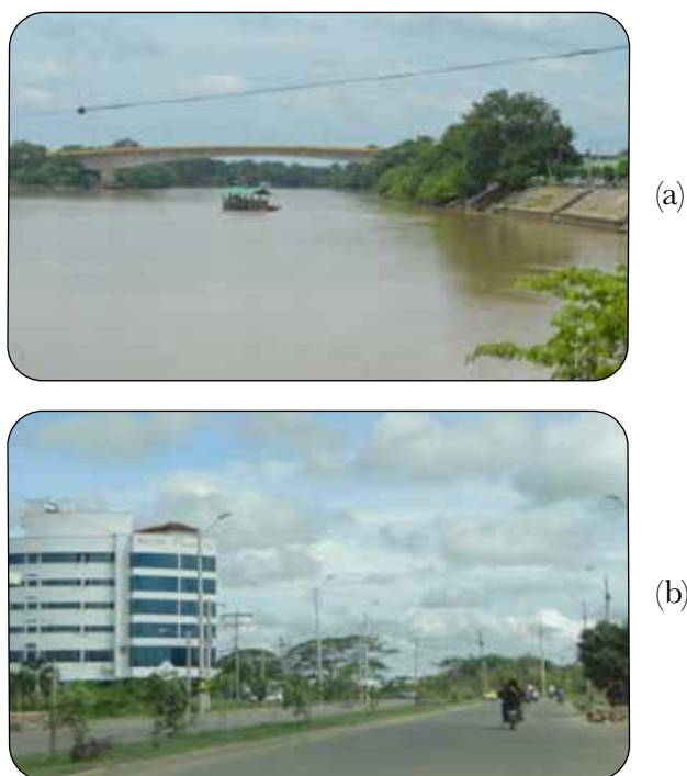
Figura 3.3. En el panel (a) está el Puente Segundo Centenario. En el panel (b) se tiene la ampliación de la calle 41. Las fotografías son el resultado del trabajo de campo realizado en 2018.
