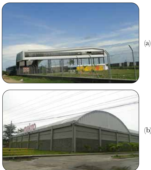
Figura 3.5. En el panel (a) se tiene el Megacolegio Los Colores. En el panel (b) está el Almacén Makro. Las fotografías son el resultado del trabajo de campo realizado en 2018.
