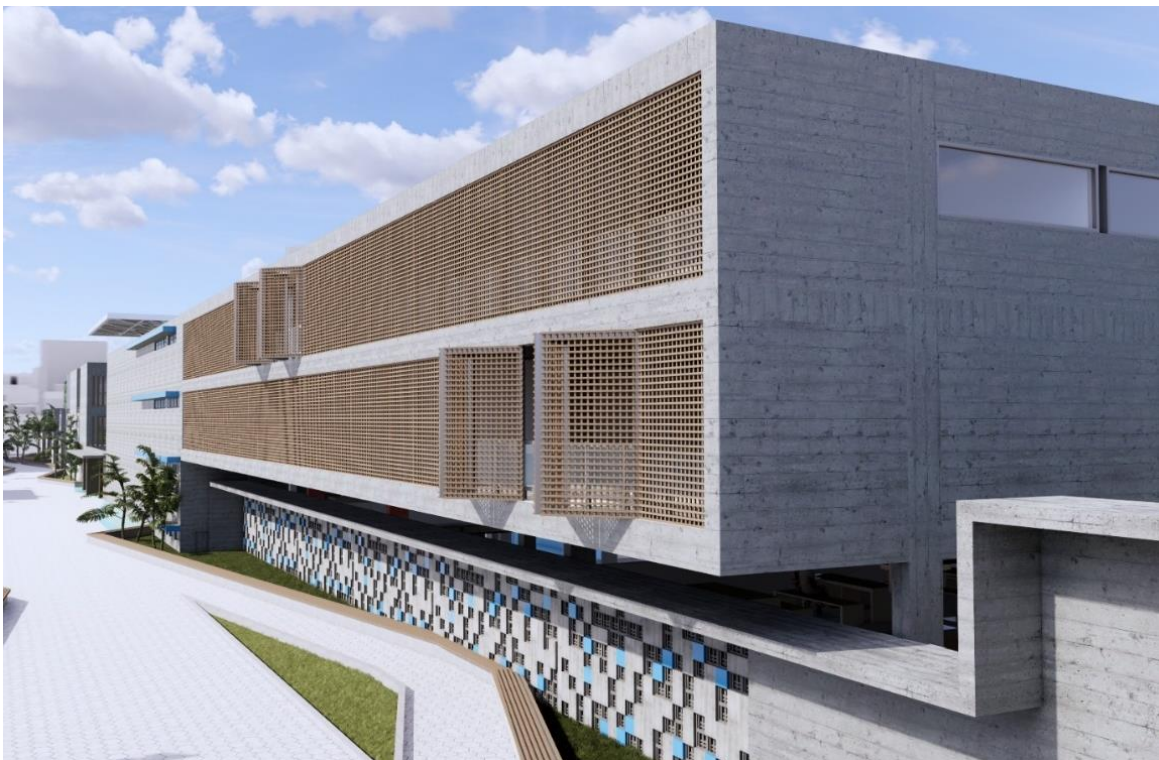
FIGURA N° 106: Lamas para incidencia solar
