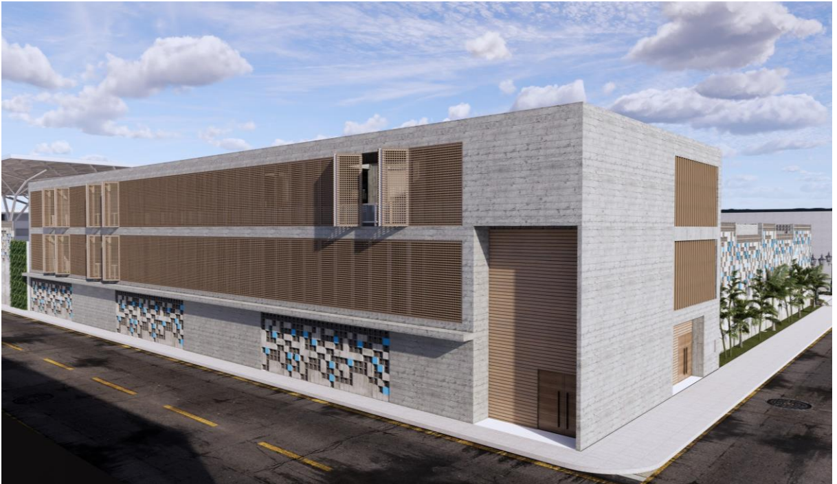
FIGURA N° 114: Fachada de la calle Rebagliati, bloque de servicios complementarios primaria
