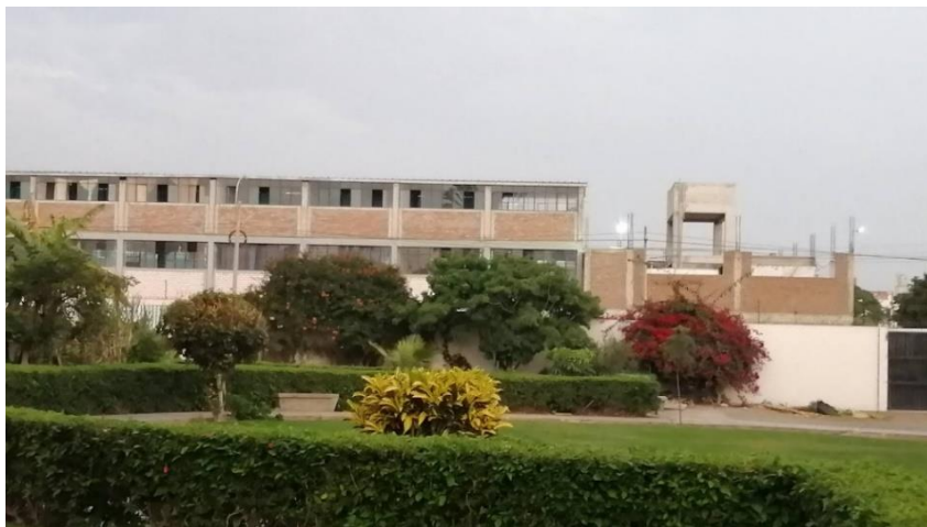
FIGURA N° 21: Ampliaciones de construcción informales de la I.E.
