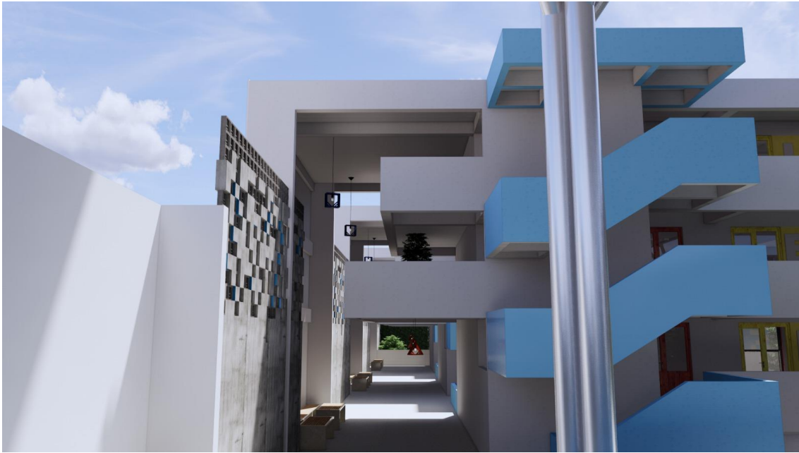
FIGURA N° 86: Triple altura en bloques de aulas de secundaria
