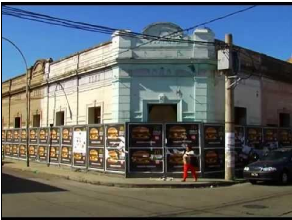
Chubut y Santa Rosa hoy. Viviendas tapiadas para construir allí nuevo emprendimiento.
