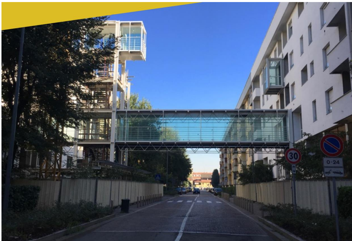
Figure 11. Laboratorio di Renzo Piano, via Ucelli di Nemi, Ponte Lambro.
