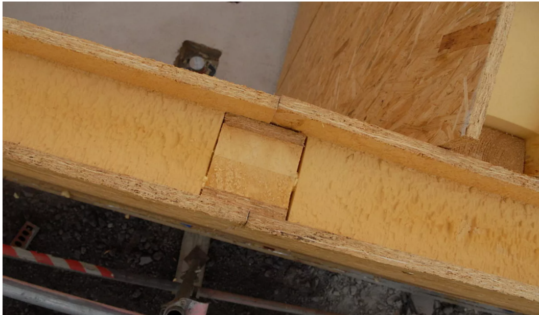
Kuva 2.4. Sips-elementtien välinen liitos, Sips@clay
