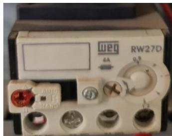
Figura 115: Relé térmico de protección para el motor
