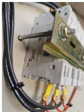
*Figura 120:* Interruptor termomagnético 20 A
