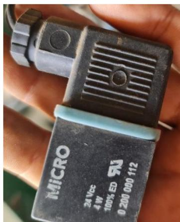
*Figura 123:* Dispositivo de mando de la electroválvula
