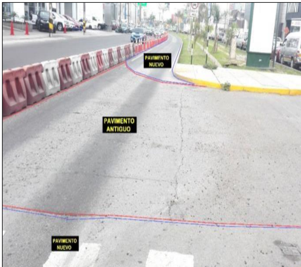
Figura 69. Fotografía de la vía en estudio.
