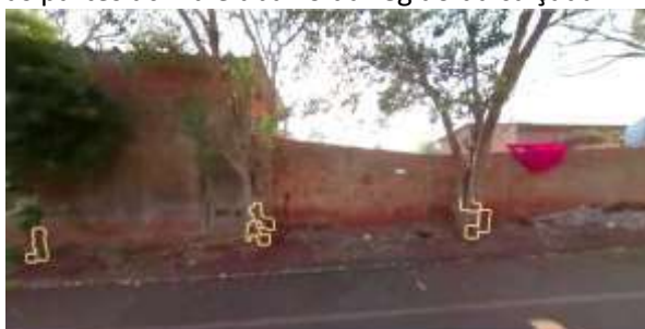
Figura 22. Após eliminação das partes acima e abaixo da região da calçada.
