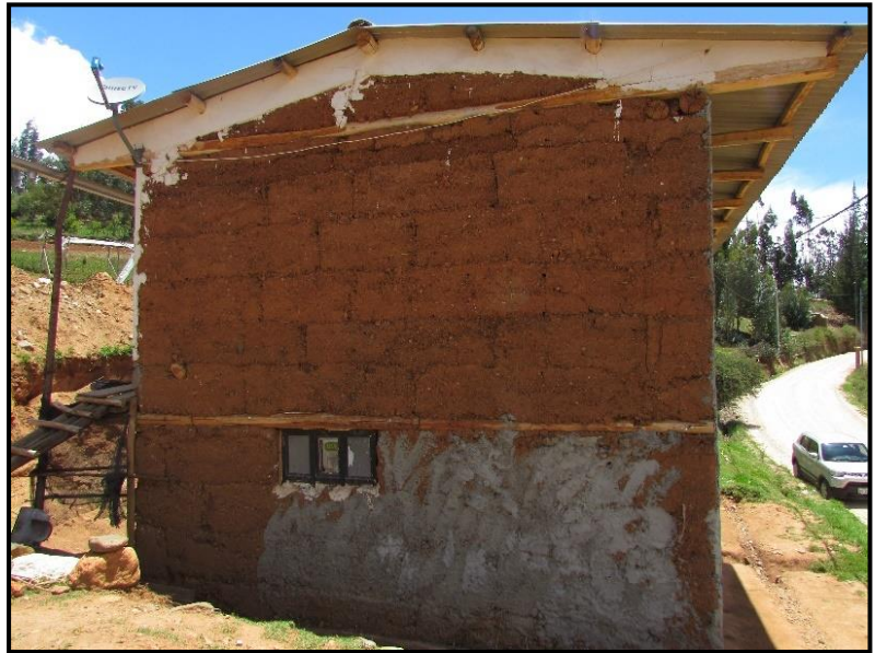
Figura 22: vivienda que uso en sus muros tapias de arcilla de Anta
