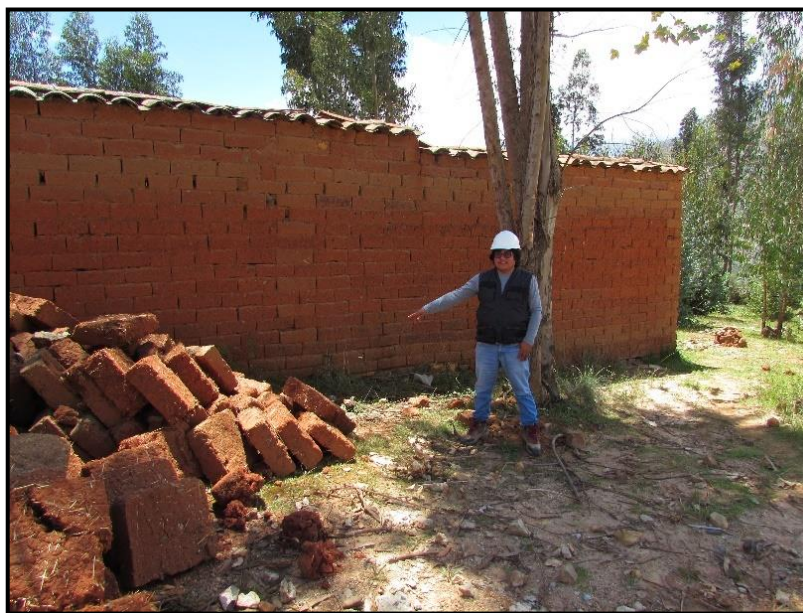
Figura 19: uso de arcilla en adobes en de viviendas en distrito de Anta
