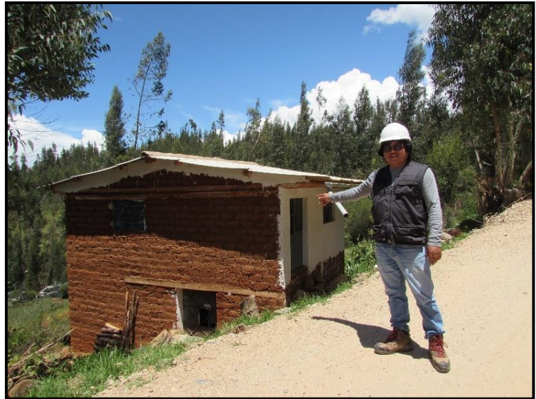
Figura 20: uso de arcilla en adobes en de viviendas en distrito de Anta
