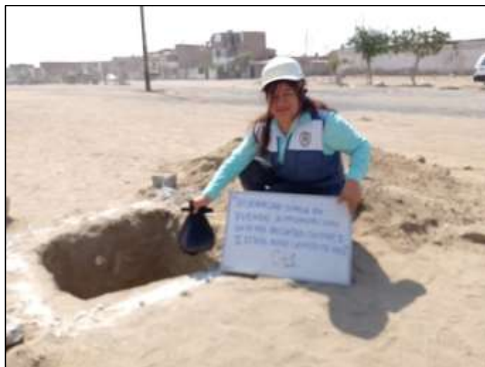
Figura N° 233 –Toma de muestra de Calicata C-1
