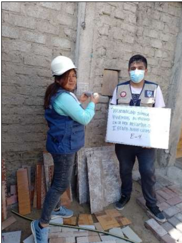
Figura N° 259 –Esclerometría E-4 Se observa los golpes con el esclerómetro (total 16). Columna
