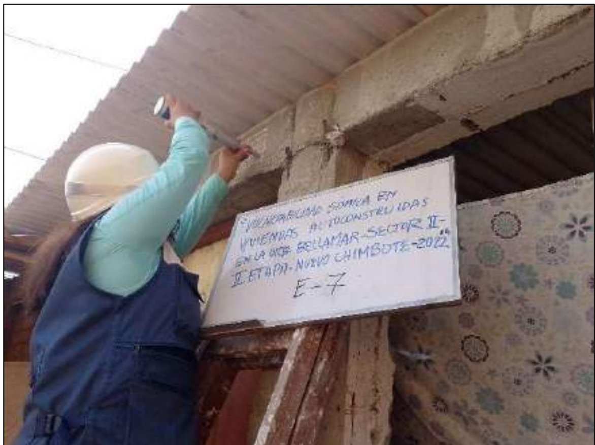
Figura N° 268 –Esclerometría E-7 Se observa los golpes con el esclerómetro (total 16). Viga
