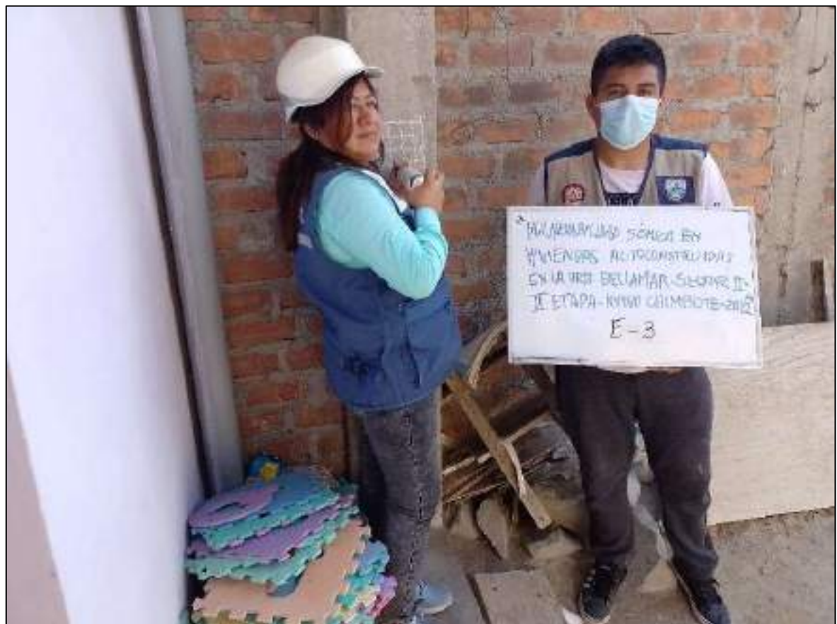
Figura N° 256 –Esclerometría E-3 Se observa los golpes con el esclerómetro (total 16). Columna
