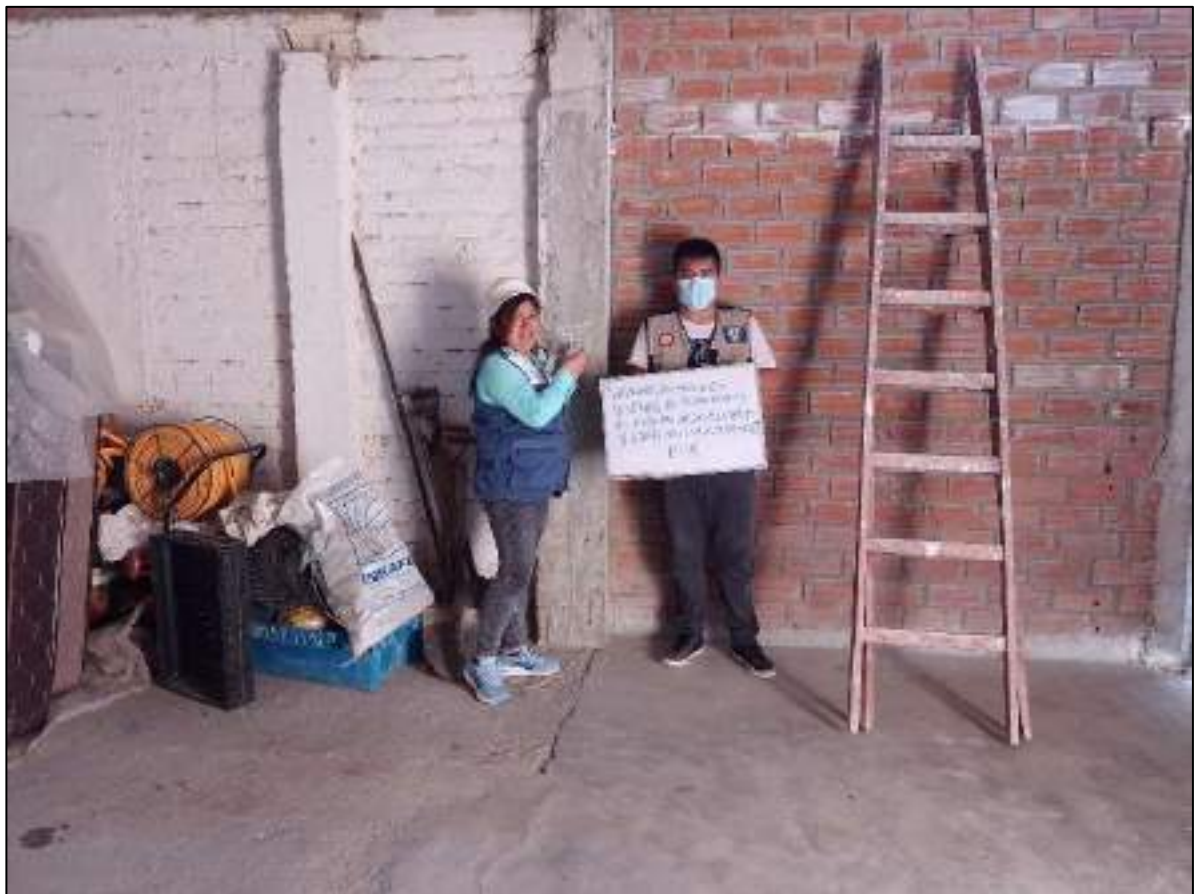
Figura N° 262 –Esclerometría E-5 Se observa los golpes con el esclerómetro (total 16). Columna
