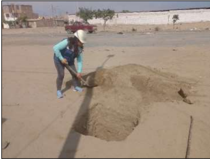
Figura N° 231 –Excavación de Calicata C-1
