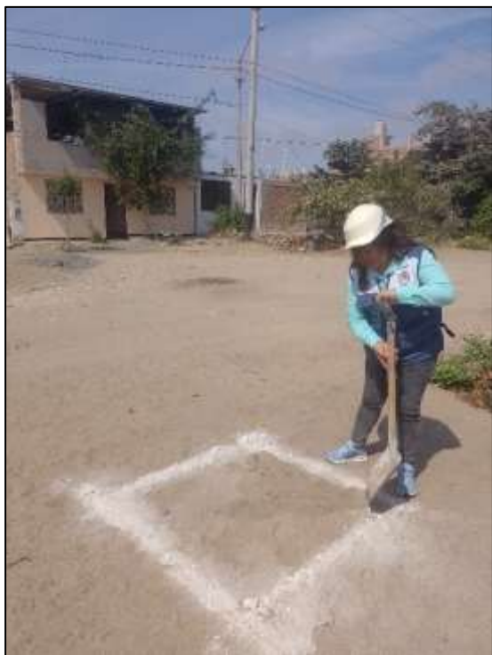
Figura N° 239 –Excavación de Calicata C-2
