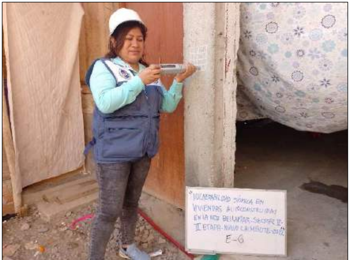
Figura N° 265 –Esclerometría E-6 Se observa los golpes con el esclerómetro (total 16). Columna
