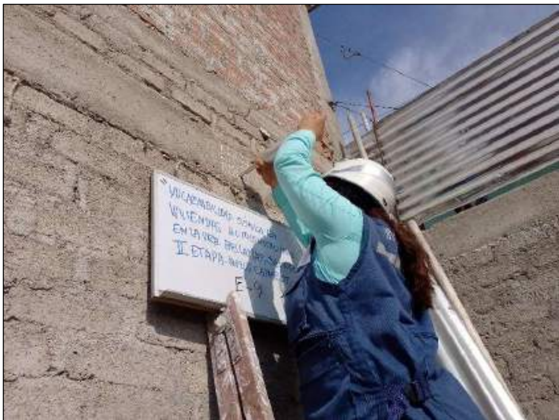
Figura N° 274 –Esclerometría E-9 Se observa los golpes con el esclerómetro (total 16). Viga
