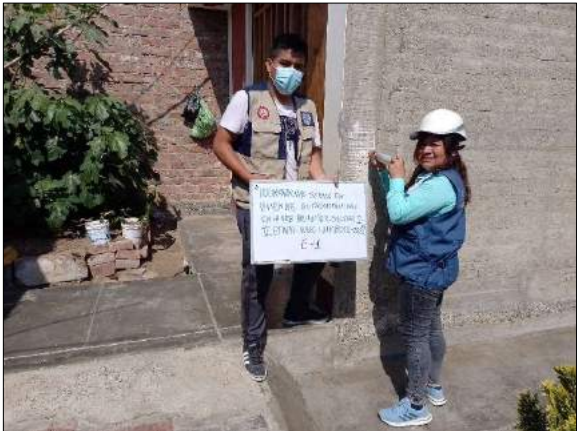
Figura N° 250 –Esclerometría E-1 Se observa los golpes con el esclerómetro (total 16). Columna
