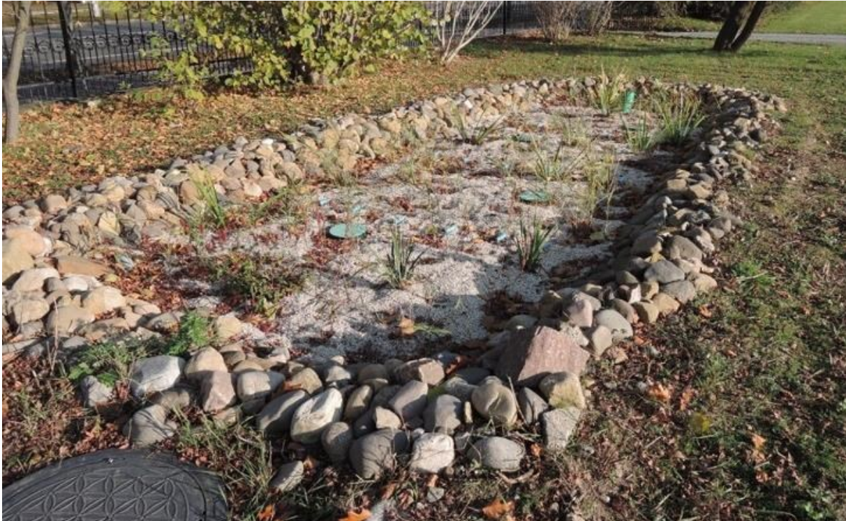
Abbildung 2.1-7: Pflanzenkläranlage zur Vorreinigung des aus dem Verwaltungsgebäude ausgeleiteten Grauwassers.
