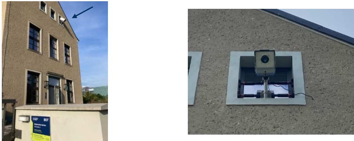
Abbildung 7.1-3: Position und Ausrichtung des Infrarotsensors am Verwaltungsgebäude des Botanischen Gartens. Das Messfeld entspricht etwa dem Fotoausschnitt in Abbildung 7-4 (Foto: V. Goldberg, 11.08.2021 und 07.09.2022).
