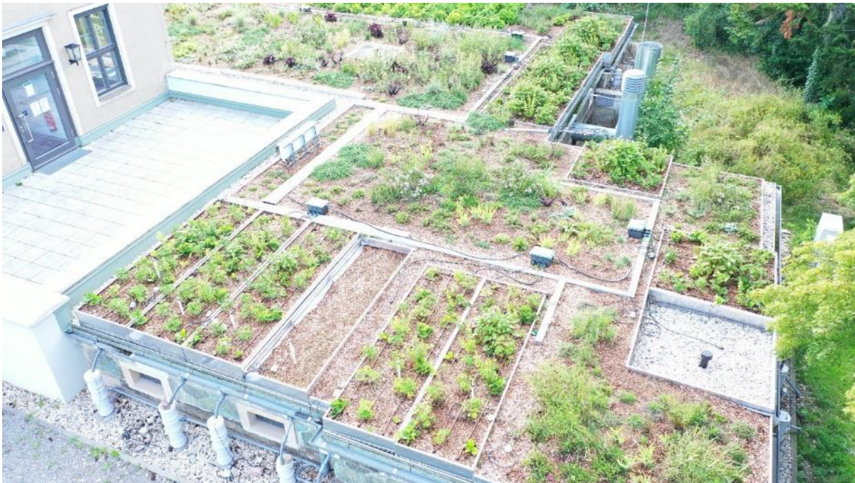
Abbildung 2.1-1: Vogelschau auf das Sockelgeschoss von Nord-Osten mit angrenzendem Eingangsbereich.
