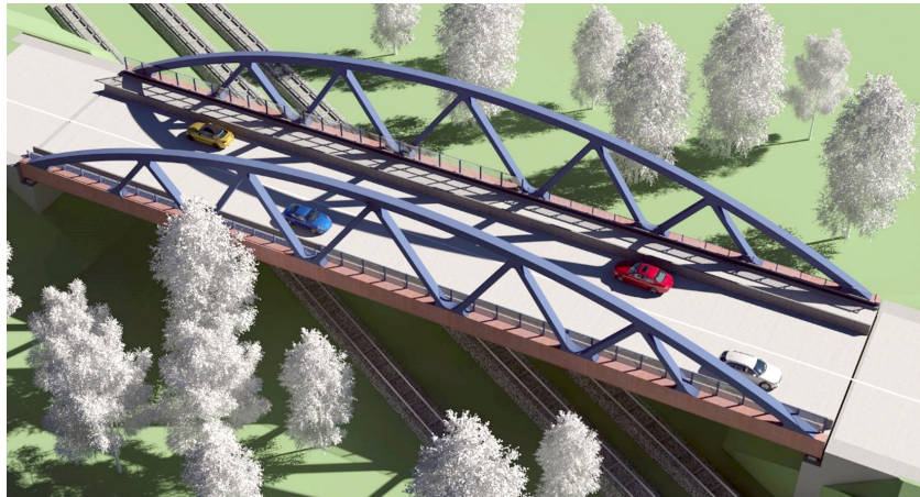
Bild 2 Visualisierung der Brücke im Zuge der Willy-Brandt-Straße Wesel mit einem Bogenfachwerk in Kombination mit direkt befahrenen Fahrbahnmodulen Visualisierung: Firmengruppe Max Bögl
