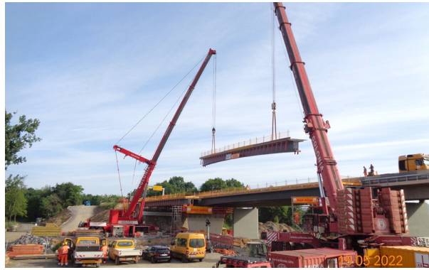
Bild 11 Einhub der Verbund-Fertigteil-Träger mit vorinstallierter Absturzsicherung im Solohub im Randfeld (links) und im Tandemhub im Mittelfeld (rechts)
