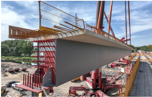
Bild 11 Einhub der Verbund-Fertigteil-Träger mit vorinstallierter Absturzsicherung im Solohub im Randfeld (links) und im Tandemhub im Mittelfeld (rechts)
