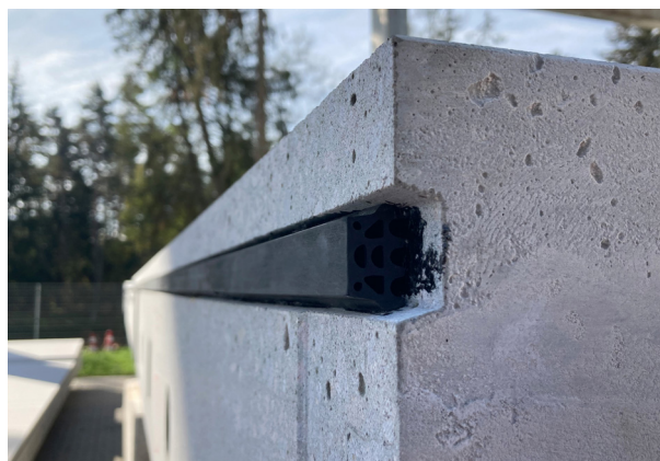
Bild 3 Fertiggestelltes direkt befahrbares Fahrbahnmodul im Werk mit Blick auf die geschliffene Stirnfläche (links) und Detail der eingelegten Tübbingdichtung (rechts) Fotos: Th. Frieß
