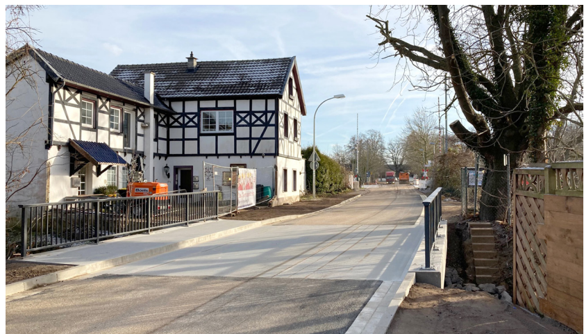
Bild 15 Fertiggestelltes Bauwerk mit modularen direkt befahrenen Platten über den Veybach Foto: B. Gericks u. T. v. d. Bosch
