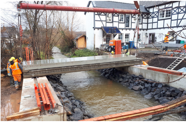
Bild 14 Einhub und Verspannen der Fahrbahnmodule an der Veybachbrücke
