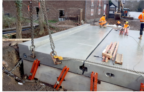
Bild 14 Einhub und Verspannen der Fahrbahnmodule an der Veybachbrücke
