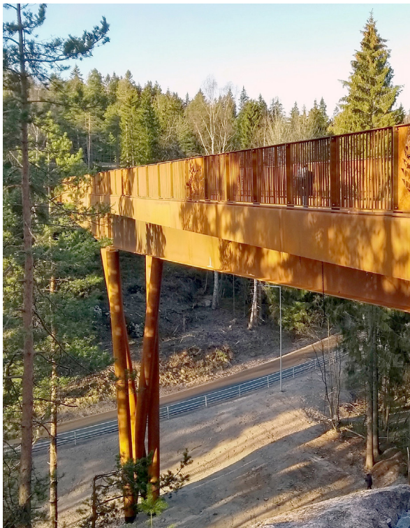
Bild 2 Fußgängerbrücke in Kuusijärvi, Vantaa, Finnland, Baujahr 2019 (Foto 2020) © Finnish Constructional Steelwork Association FCSA/Teräsrakenneyhdistys
