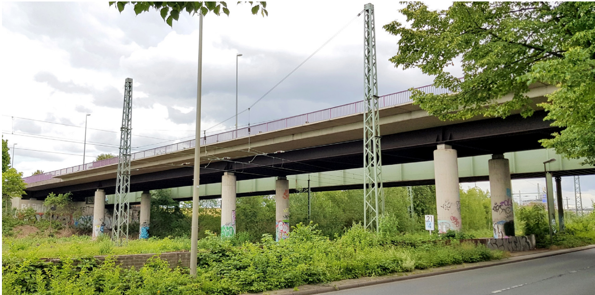
Bild 1 Verbundbrücke aus wetterfestem Baustahl über eine Bahntrasse und Straße in Dortmund, Baujahr 1990 (Foto 2022) © Peter Hatke
