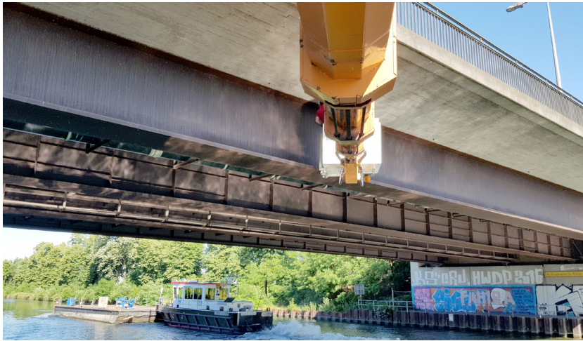
Bild 11 Prüfung einer Brücke aus wetterfestem Baustahl in Herne (Baujahr 1975, Foto 2019) © Peter Hatke
