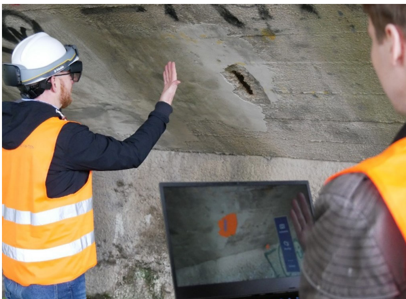
Bild 3 Praxistest des Demonstrators zur Unterstützung der Bauwerksprüfung Foto: [13]
